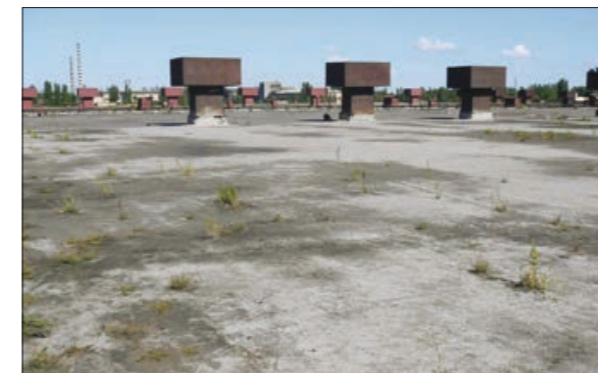
Рис. 2.9.1 Старая битумная кровля
