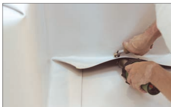
13. При помощи узкого латунного ролика приваривается переход с вертикали на горизонталь.
