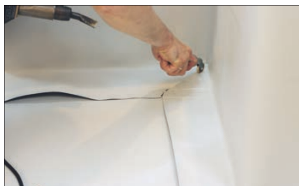
15. Приваривается перехлест материала в углах. Особенно тщательно следует приварить при помощи латунного валика границы стыков полотнищ.
