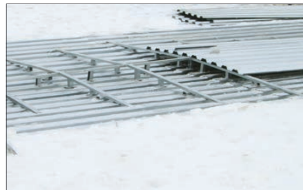
Рис. 3.3.4 Вариант устройства разуклонок
