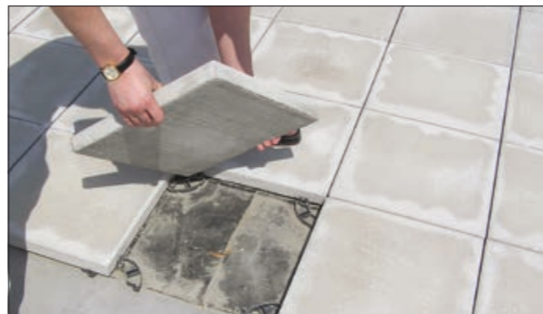
Рис. 2.7.3 Применение в качестве балласта тротуарной плитки
