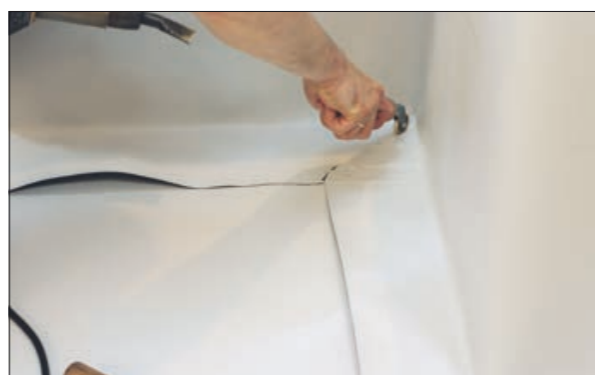
14. С помощью ручного фена приваривается перехлест на горизонтальную часть справа. Ширина шва не менее 30 мм.
