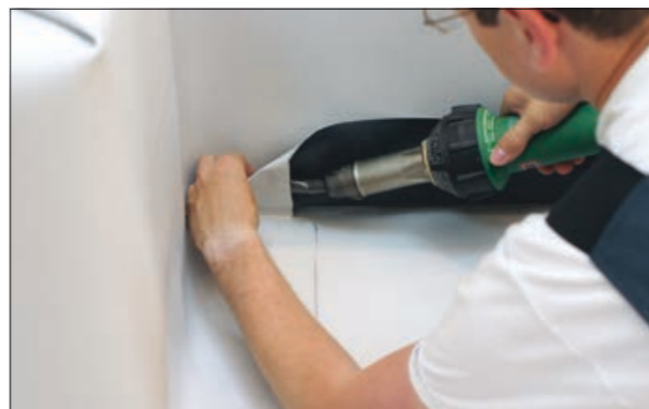
12. Особенно тщательно следует выполнять сварку внутренней части уголка. При работе использовать валики различной ширины.
