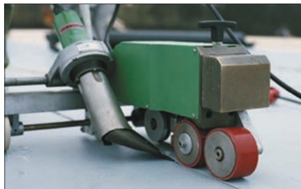
Рис. 5.2.1 Процесс автоматической сварки
