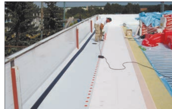
Рис.3.5.17 Монтаж метровых рулонов ТЕХНОНИКОЛЬ
