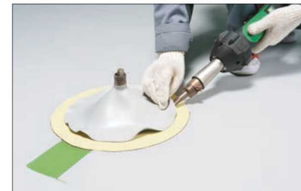
26. Точечно прихватите конус за «юбку» к основному кровельному ковру.
