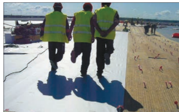
Рис. 5.4.3 Натягивание рулона
