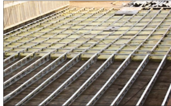
Рис. 3.3.3 Вариант устройства разуклонок
