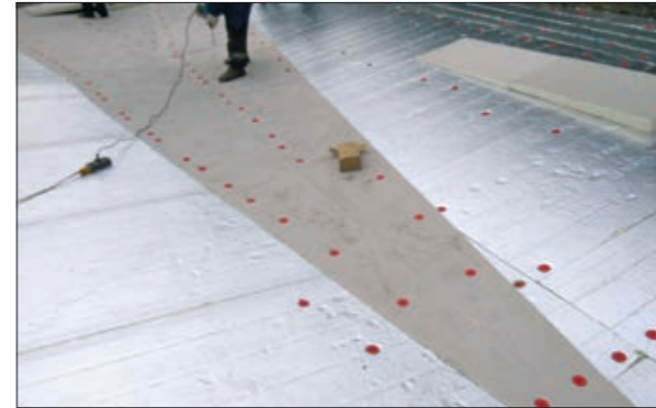
Рис. 3.3.16 Изображение разуклонки в ендове между воронками
