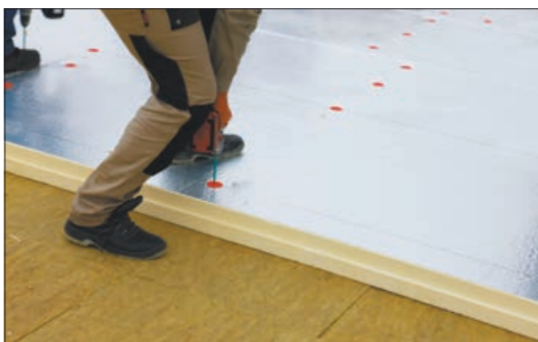
Рис. 2.4.1 Монтаж системы ТН-КРОВЛЯ СМАРТ PIR
