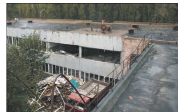
Рис. 2.9.2 Вид кровли после ремонта полимерными мембранами с доутеплением
