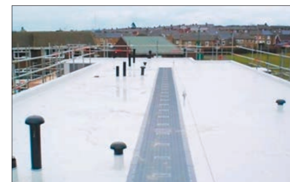
Рис. 4.2.5 Пешеходная дорожка ТЕХНОНИКОЛЬ на кровле
