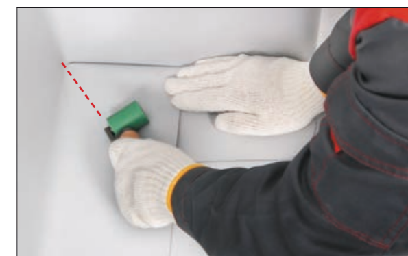
4. Переложите петлю на другую сторону и повторите прикатку места сгиба с обратной стороны.
