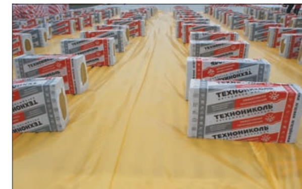
Рис. 3.1.4 Укладка пароизоляционной пленки ТЕХНОНИКОЛЬ
