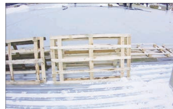
Рис. 3.1.9 Защита края кровельного пирога от хождения
