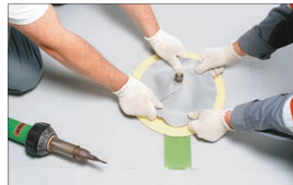
25. Быстрым движением, не допуская остывания мембраны, наденьте конус на элемент малого диаметра.
