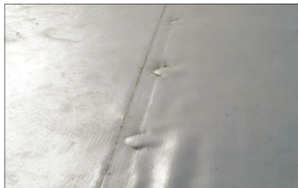
Рис. 3.5.7 Дефект сварного шва
