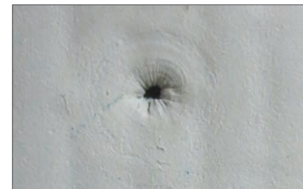
4.3.5 Повреждение на образце мембраны после испытания
