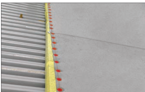
Рис. 3.1.7 Защита теплоизоляции от намокания
