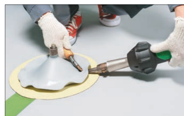
27. Сделайте воздушный карман с помощью латунного ролика. При этом давите латунным роликом «наружу», чтобы обеспечить необходимое натяжение мембраны.
