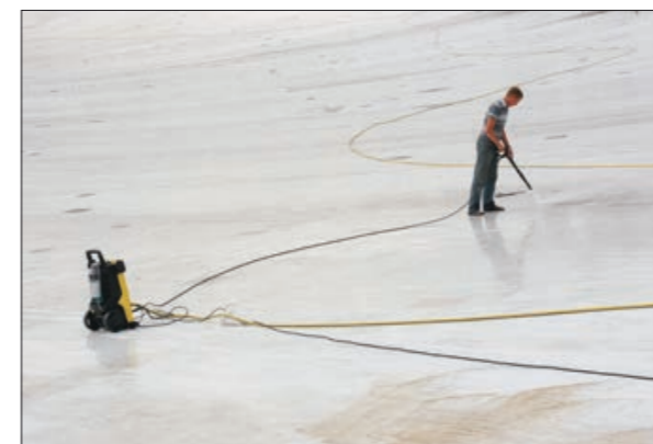
Рис. 2.9.5 – Рис. 2.9.6 Подготовьте старое основание: очистите, обеспыльте, просушите
