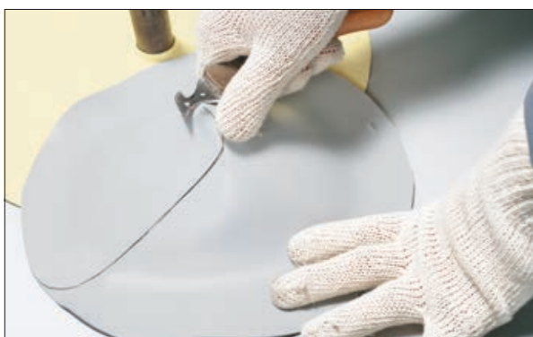
23. Сделайте надрез кровельным ножом на вершине конуса.
