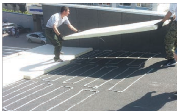
Рис. 2.9.4 Приклеивание плит PIR на Клей-пену
