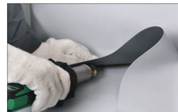
2. Для удобства работы прикатайте мембрану вдоль ребер угла латунным роликом и прихватите к основному кровельному ковроу с помощью ручного фена.
