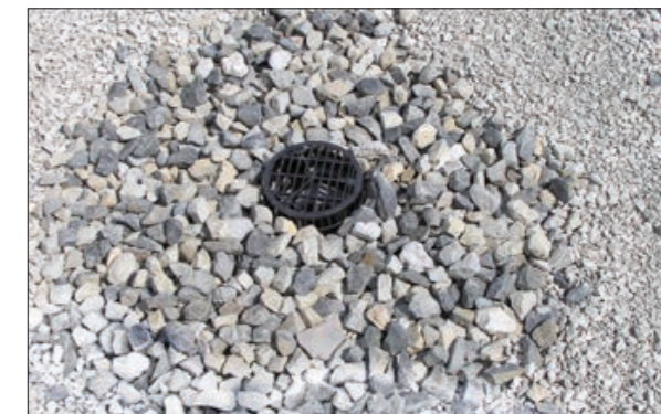
Рис. 2.7.5 Увеличение фракции балласта вокруг воронки
