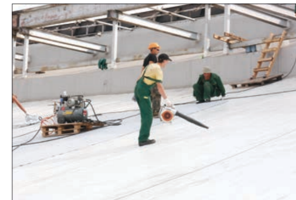
Рис. 2.9.5 – Рис. 2.9.6 Подготовьте старое основание: очистите, обеспыльте, просушите
