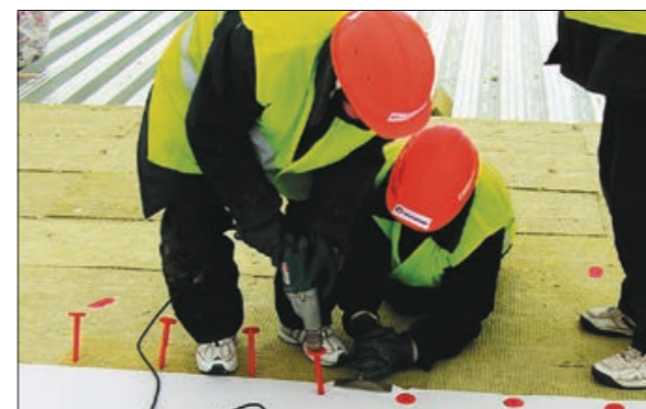
Рис. 5.4.5 Натяжение мембраны
