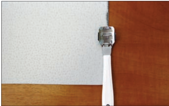
Рис. 5.2.15 Фиксация Т-образного шва металлической пластиной
