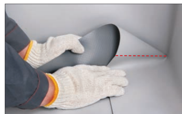
5. Сдвиньте мембрану таким образом, чтобы линия сгиба оказалась посередине петли.
