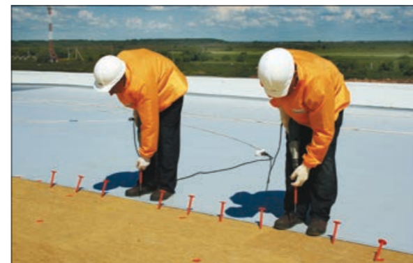
Рис. 5.4.4 Механическое крепление мембраны
