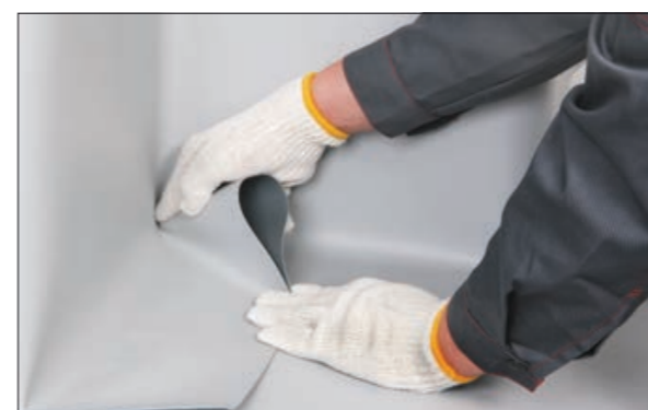
1. Во внутреннем углу сформируйте петлю из материала. Начальная точка петли должна располагаться точно в вершине угла между парапетами.
