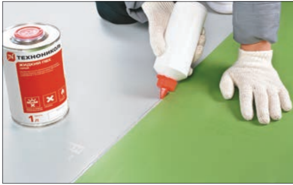
Рис. 3.4.2 Обработка стыка жидким ПВХ
