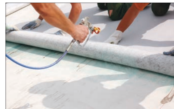
Рис. 2.9.7 Процесс нанесения клея на основание и на мембрану
