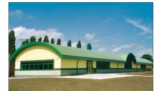
Рис. 4.8.2 Вид мембранной кровли с имитацией фальца
