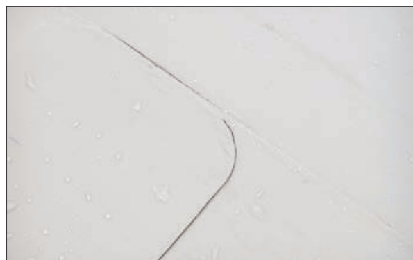
Рис. 5.4.1 Скругление углов мембраны
