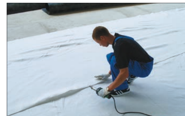
Рис. 3.3.1 Сварка полотнищ геотекстиля между собой
