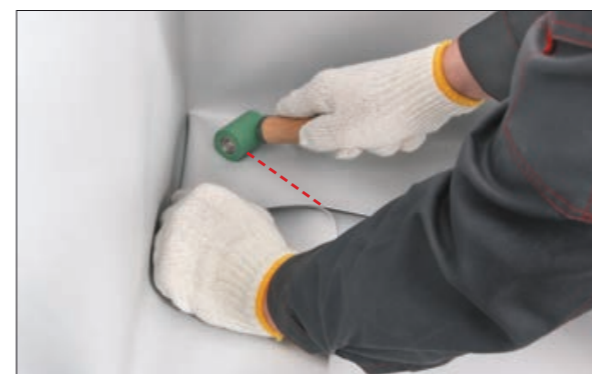
3. Прижмите петлю мембраны к горизонту и прикатайте место сгиба роликом.
